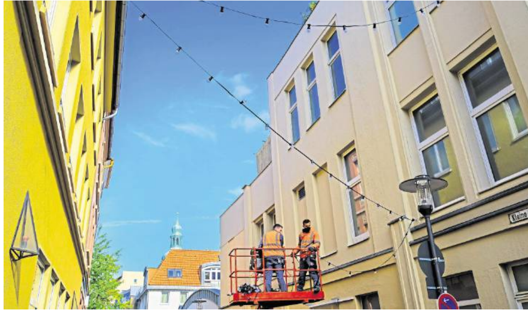
Mitarbeiter der Kommunalen Servicebetriebe haben gestern mit der Installation der insgesamt 120 Lichterketten begonnen. —FOTO: KLEINE
